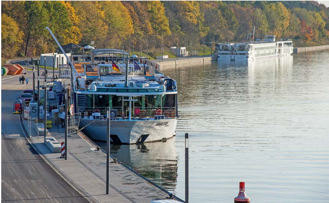
Fünf Anlegestellen sind bereits fertig, fünf weitere folgen bis Ende 2015. Foto: Christine Dierenbach
