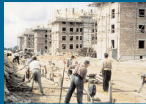
Bauarbeiter vor den ersten im Rohbau fertig gestellten Wohnblocks in der Reinerzer Straße.
