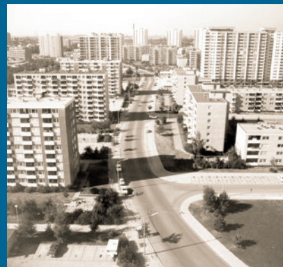
Der Nordwestteil Langwasser wurde nicht in der Planungsträgerschaft der wbg realisiert, sondern der Bauträger Neue Heimat errichtete hier im sozialen Wohnungsbau Hochhaustypen, die bereits in anderen Vorstadtsiedlungen gebaut worden waren.
