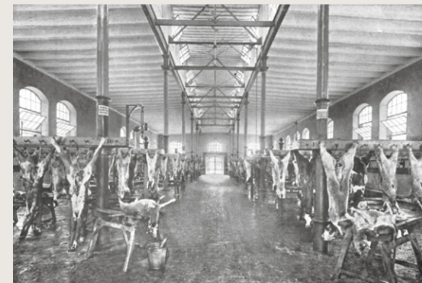
Innenansicht der Kleinviehschlachthalle (Quelle: Das städtische Verwaltungswesen, Nürnberg, 1906)
