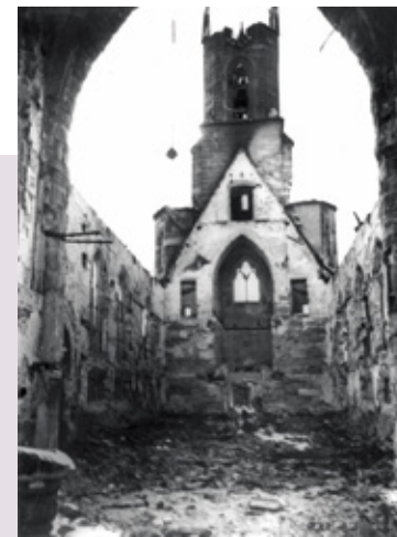
Blick auf die zerstörte Kirche St. Leonhard (Quelle: privat)
