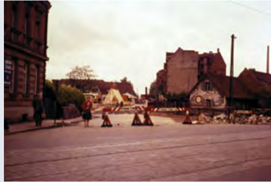
1960: Nördliches Ende der Turnerheimstraße: Während der Kirchweih (Schiffsschaukel) wird die Nopitschstraße ausgebaut
