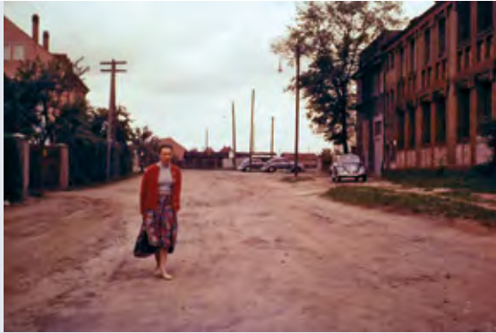
1960: Blick in die umgekehrte Richtung – Man beachte die Holzmasten der Strombeleuchtung und den Strommast!
