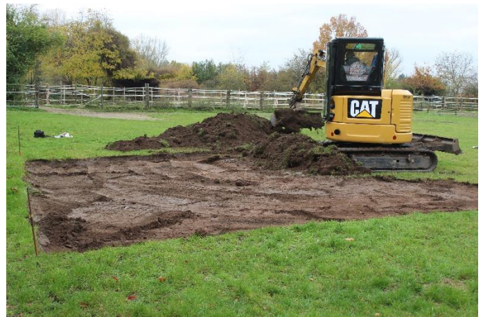
Abb. 35: Oberbodenabtrag in Sondage 16, von N.
