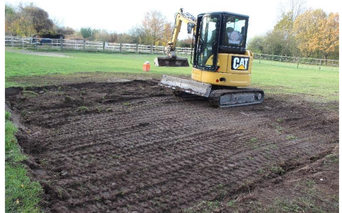
Abb. 38: Verdichten der wiederverfüllten Sondage, von NO.
