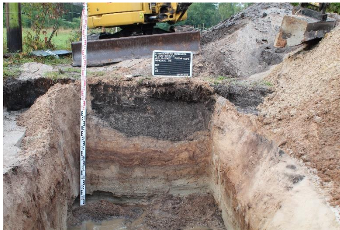
Abb. 84: Tiefensondage in Sondage 38, von N.
