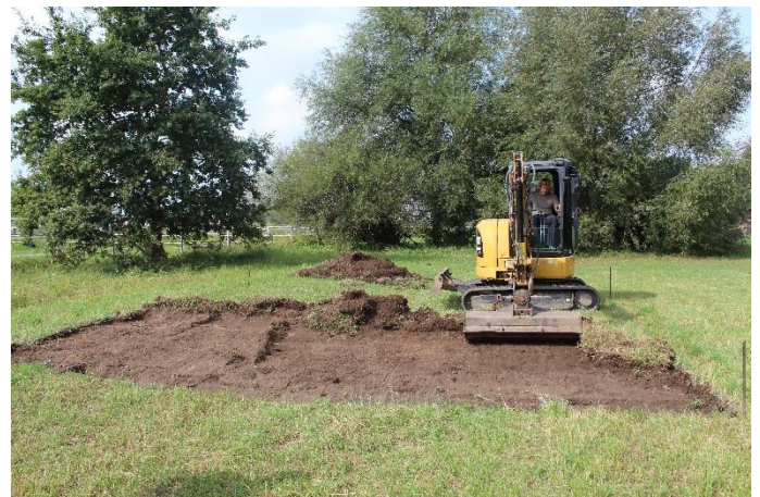
Abb. 39: Oberbodenabtrag Sondage 17, von O.
