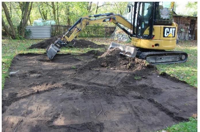
Abb. 72: Oberbodenabtrag in Sondage 25, von ONO.
