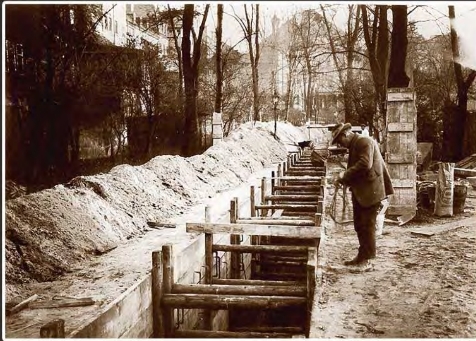
Rohrgraben mit Holzverbau. Im Hintergrund die Rückseiten der Bebauung an der Ringstraße (Spittlertorgraben). Foto vom 5. Dezember 1928
