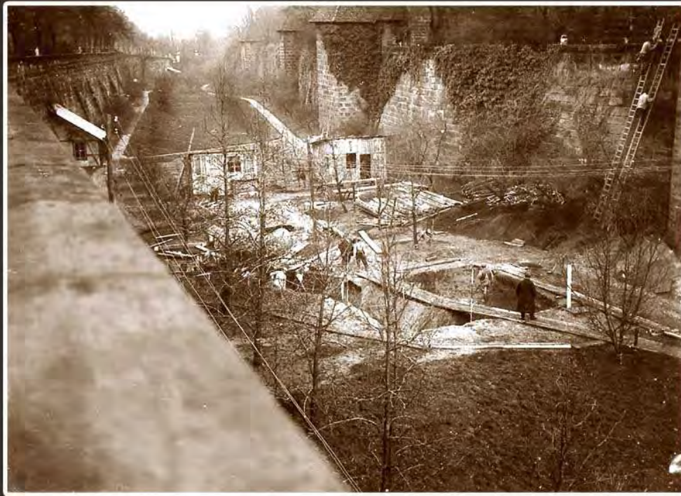
Die Kanalbaustelle im Spittlertorgraben, Bild 1
