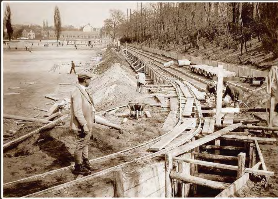
Rohrgraben mit Holzverbau im Bereich der Sportplatz-Tribünen an der Deutschherrnwiese. Blick nach Osten in Richtung Altstadt. Rechts oberhalb der Böschung befindet sich die Deutschherrnstraße. Foto vom April 1928
