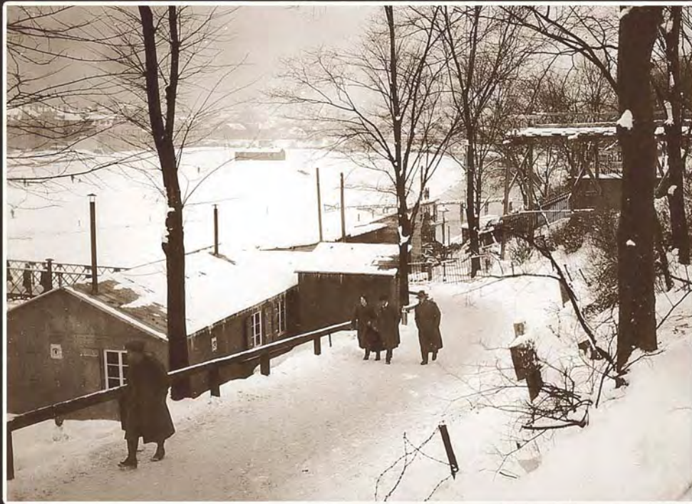
Die Baustelleneinrichtung am südlichen Ende des Ledererstegs. Vorne links die Kantinenbaracke, im Hintergrund rechts die Betonmischanlage. Blick nach Osten in Richtung Johannisbrücke. Foto vom 28. Januar 1929
