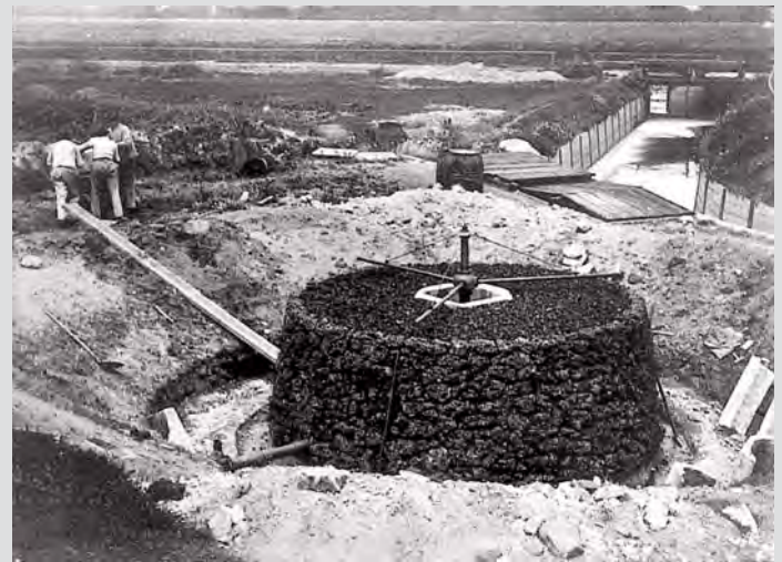
Der Versuchstropfkörper ist aus Steinen aufgeschichtet. Das Wasser wird mit einem Drehsprenger verteilt. Rechts der Auslaufkanal der Kläranlage Süd, der zur Pegnitz führt.
