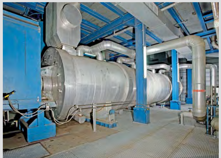
Die Schlamm-trocknungsanlage im Klärwerk 1: Zweistufige Trocknung, das Endprodukt ist staubförmig und wird zu Pellets gepresst. Hier einer der beiden Trockner.
