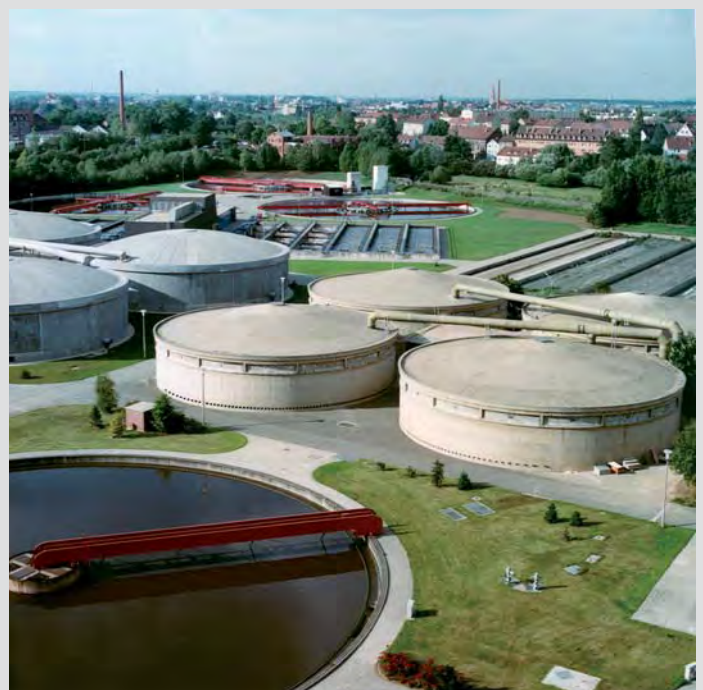
So zeigt sich das Klärwerk 1 ab 1975: Tropfkörper als erste, Belebungsanlage als zweite biologische Reinigungsstufe.
