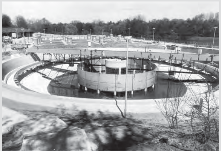
Ein Blick auf die erste biologische Stufe des Klärwerks 2 kurz nach ihrer Inbetriebnahme.
