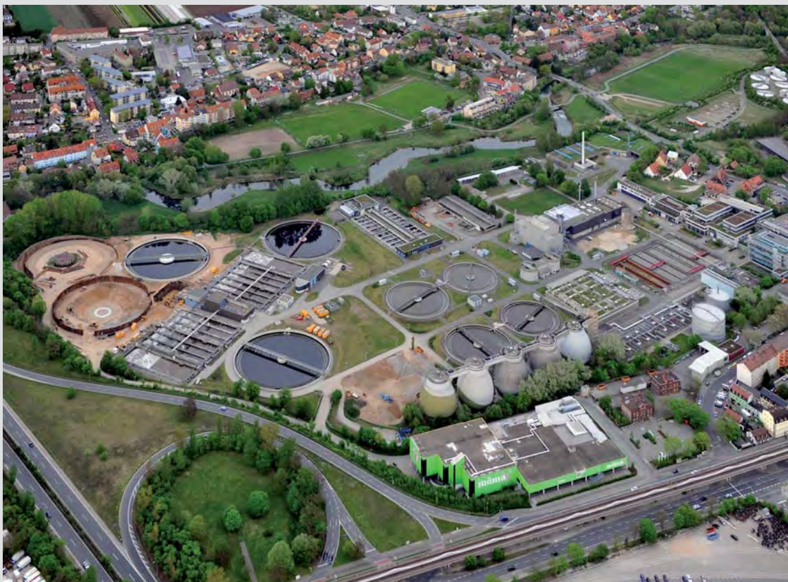
Das Klärwerk 1 im Jahr 2012. Zweistufige biologische Reinigung (zwei Belebungsanlagen), die Nachklärbecken werden erneuert.
