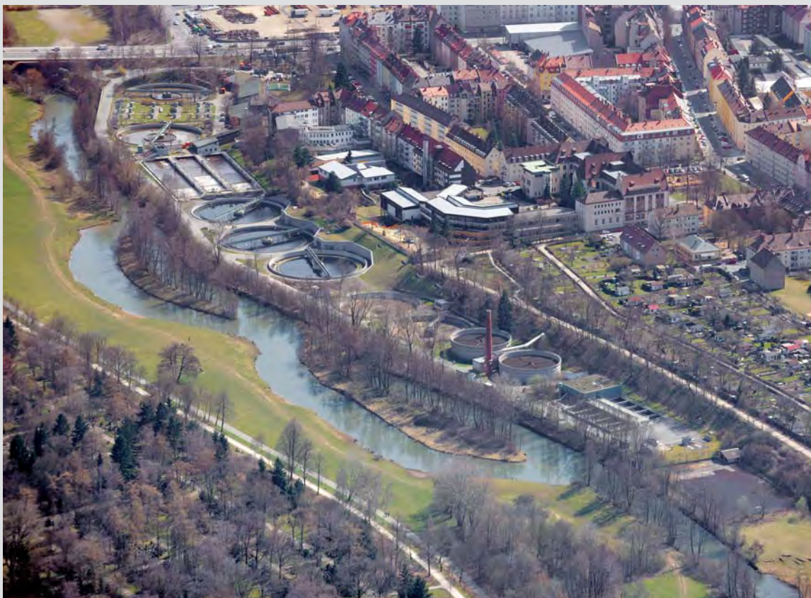
Das Klärwerk 2 heute. Zweistufige biologische Reinigung (zwei Belebungsanlagen), Abwasserfilter. Zwei Tropfkörper sind noch vorhanden, aber außer Betrieb.
