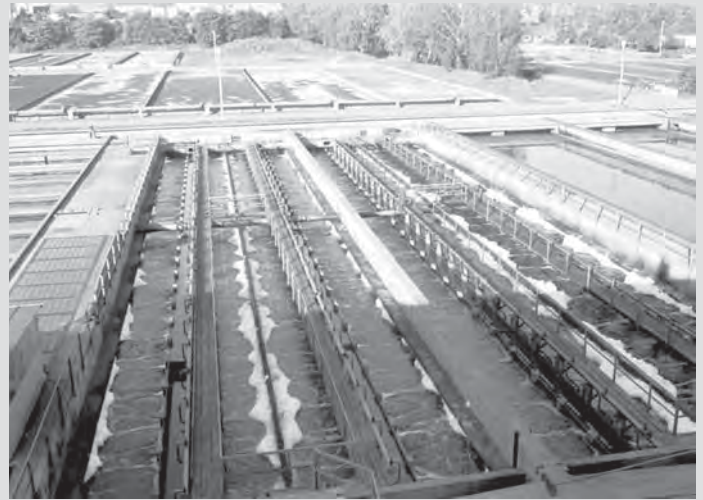
Ansicht der Belebungsanlage. Ganz rechts die Vorklärbecken, in der Mitte die Belebungsbecken, links am Bildrand die Nachklärbecken.
