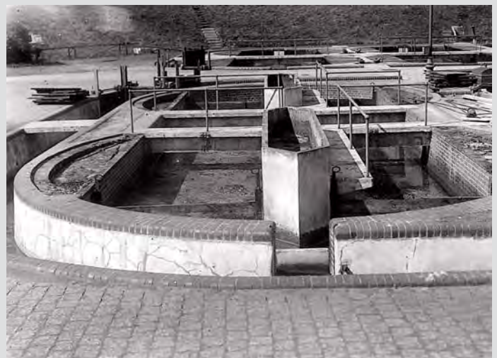
Emscherbrunnen im Detail. In der Mitte der Schacht des Faulraums, um ihn herum der Absetzraum. Das gereinigte Abwasser würde in den Ringkanal überfließen – wenn dieser Emscherbrunnen nicht außer Betrieb wäre...
