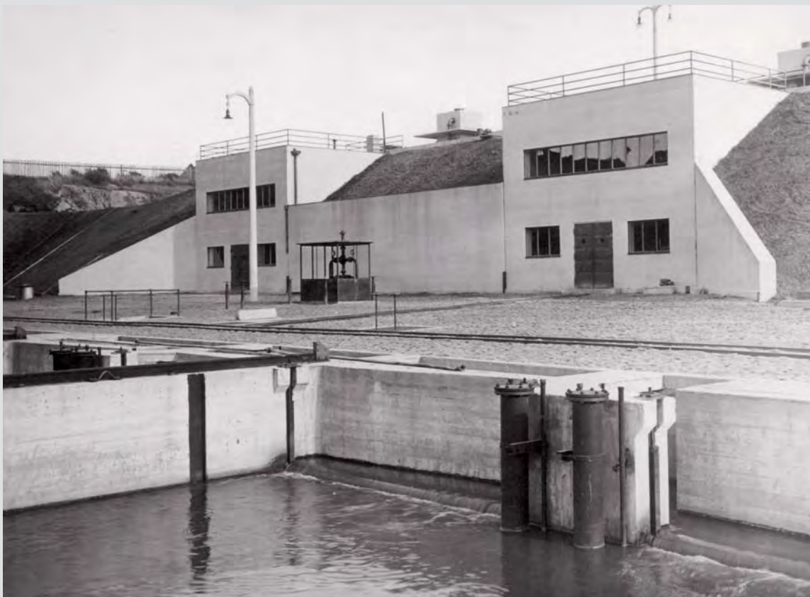
Die Faulbehälter der Kläranlage Nord. Sie sind an die südliche Hangkante des Pegnitztals gebaut.
