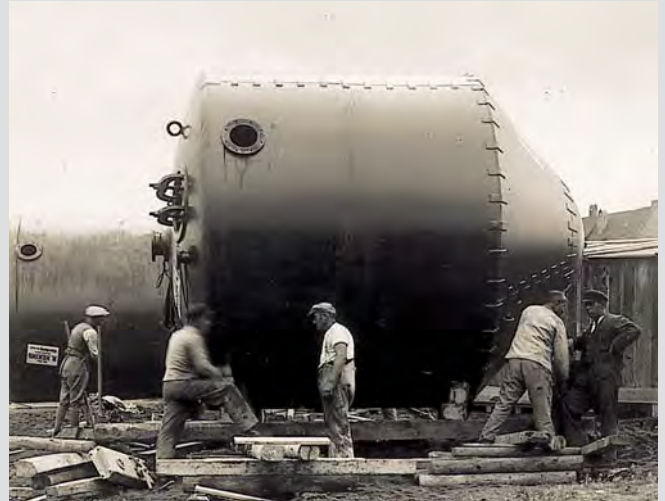
1930. Kläranlage Nord, Druckbehälter für Schlammförderung.
