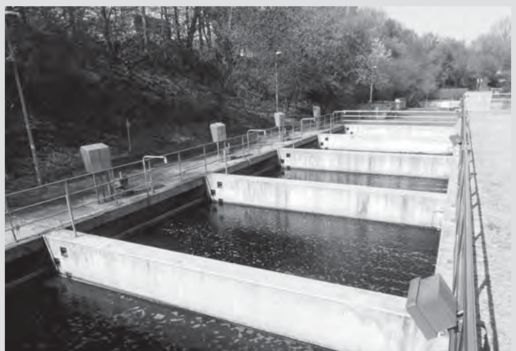
Der Abwasserfilter im neuen Klärwerk 2.
