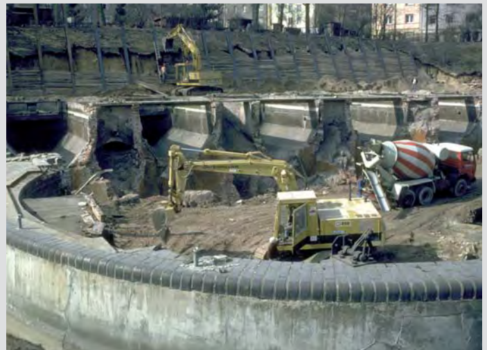
Bauarbeiten am neuen Klärwerk 2. Abbruch der Emscherbrunnenanlage.
