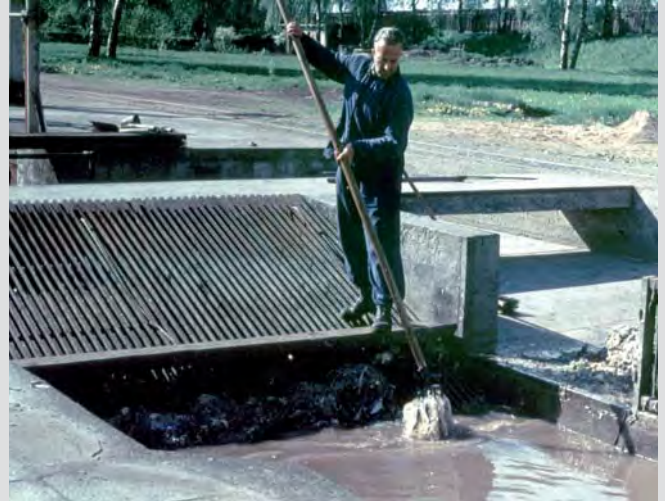
ca. 1960. Kläranlage Nord (Klärwerk 1), Rechenanlage.
