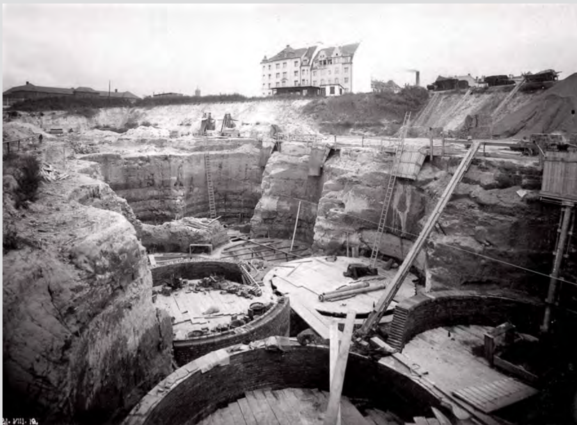
Die Emscherbrunnen werden aufgemauert. Deutlich ist der feste Sandsteinfels im Bereich der Baugrube zu erkennen.
