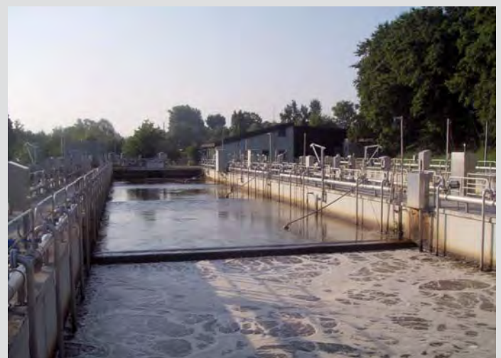
Deutlich erkennbar: Die belüftete (vorne) und die unbelüftete Zone der Belebungsbecken im Klärwerk 2 (Fließrichtung von hinten nach vorne).
