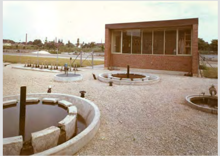
Ganz neu: Die Versuchsanlage zur zweistufigen Abwasserreinigung kurz vor ihrer Inbetriebnahme im Jahr 1966.
