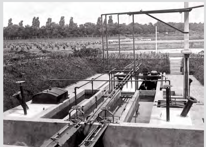
Die Versuchs-Belebungsanlage, eine Kläranlage im Kleinen.
