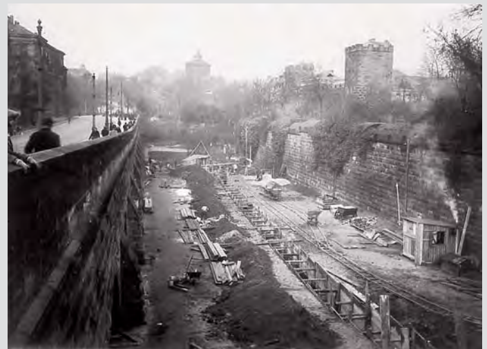
Die Baustelle des Hauptzuführungskanals im Westtorgraben. Im Hintergrund der Neutorturm.
