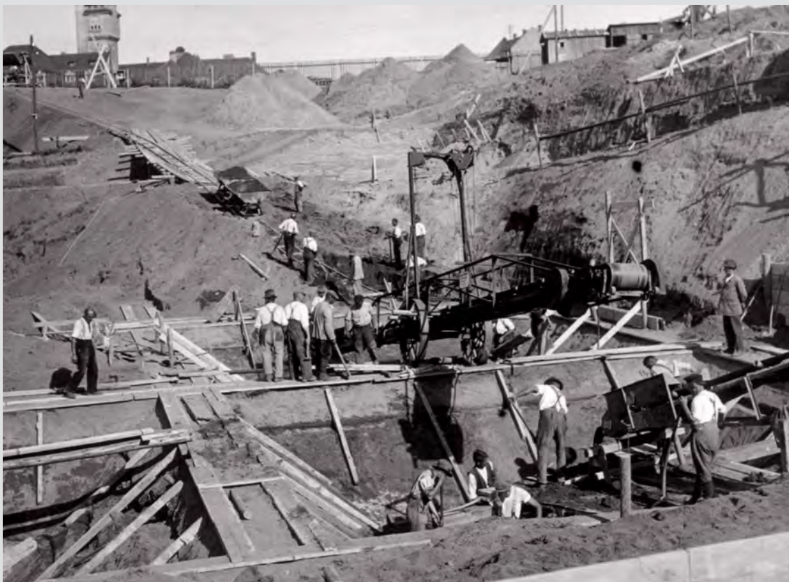
Andererseits prägt auch die Handarbeit das Geschehen auf der Baustelle. Hier entstehen die Baugruben für die Faulbehälter.
