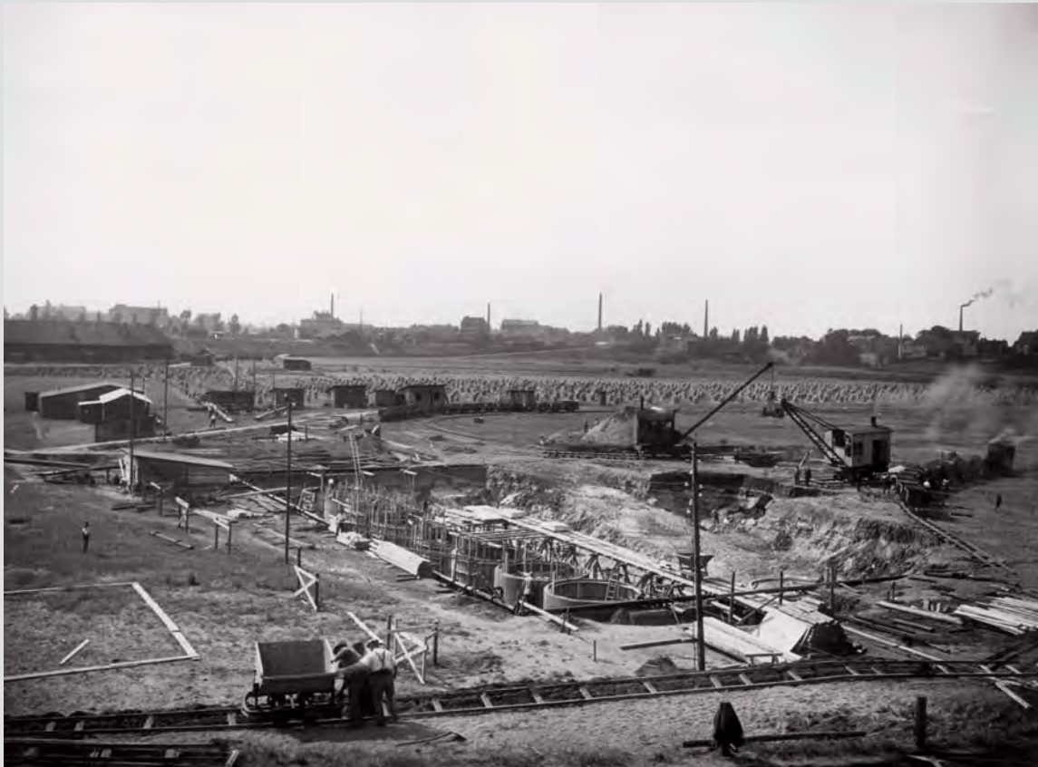
Blick über die Baustelle der Kläranlage nach Westen. Die Baugrube für die Klärbecken wird mit Dampfbaggern ausgehoben.
