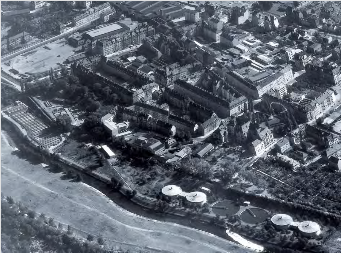
Das Klärwerk 2 im Jahr 1964. Emscherbrunnenanlage und Schlamm-trockenbeete (links), biologische Reinigung in Tropfkörpern (rechts).
