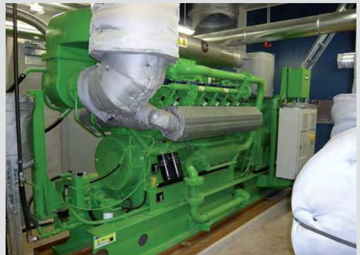
Ein Beispiel für nachhaltige Energieversorgung im Klärwerk 1: Strom- und Wärmeerzeugung aus Klärgas in Blockheizkraftwerken.
