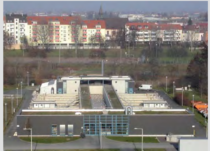
Auch die Entnahme von Schwebstoffen aus dem Abwasser gehört zur Weitergehenden Abwasserreinigung. In den Nürnberger Klärwerken wurden hierfür Abwasserfilter gebaut (hier der Abwasserfilter im Klärwerk 1).
