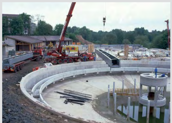
Bauarbeiten am neuen Klärwerk 2. Die erste biologische Stufe entsteht.
