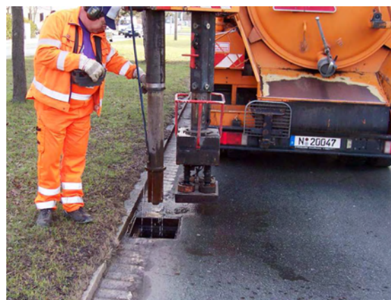
Die Reinigung von Regeneinläufen auf öffentlichen Straßen erfolgt mit dem hier gezeigten Spezialfahrzeug.
