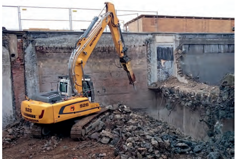
Zuerst erfolgte der Abbruch der 60 Jahre alten Schlamm Speicherbehälter. Sie werden durch runde Eindickbehälter ersetzt. Foto: SUN.
