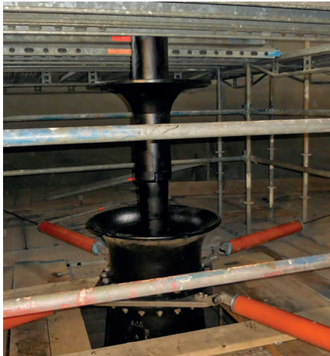
Der neu eingebaute Mischer im Inneren des Faulbehälters. Foto: SUN.
