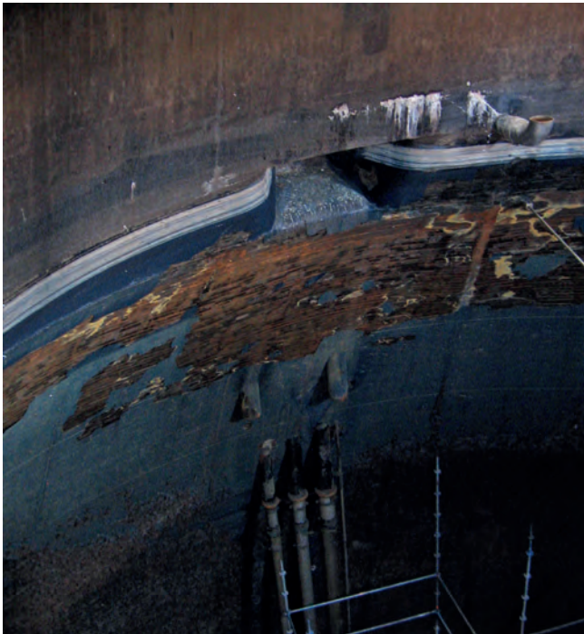
Das Innere des entleerten Faulbehälters vor der Sanierung. Foto: SUN.
