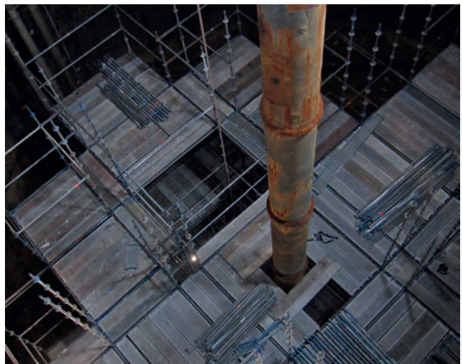
Eindrucksvoll: Die Einrüstung im Inneren des Faulbehälters. Foto: SUN.
