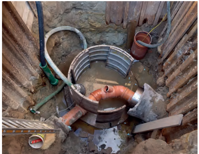
Gebietssanierung Wasserschutzgebiet Erlenstegen. Schachtneubau und provisorische Abwasserführung. Foto: SUN.
