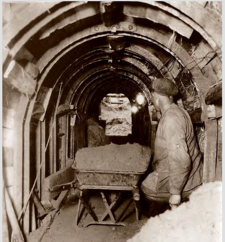
Bergmännische Unterquerung der Ringstraße vom Regenüberlauf Spittlertorgraben zur Rosenau. Der Stollen wird mit Stahl- Ausbaubögen und Holzverbau gesichert (Foto: Stadtarchiv Nürnberg).
