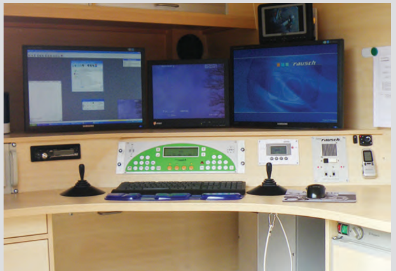
Der Bedienplatz des Kanalinspektionsfahrzeuges. Von dort kann die Kamera auf ihrem Weg durch den Kanal gesteuert werden.
