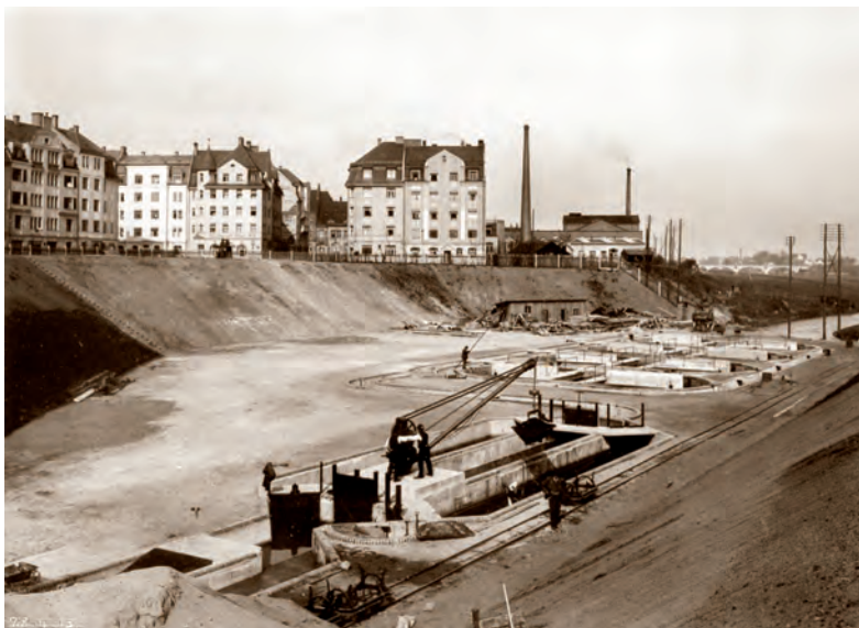
Die Kläranlage Süd kurz nach ihrer Inbetriebnahme. Fotografiert im Jahr 1913.
