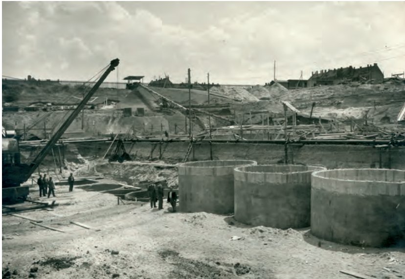
Sommer 1930: Die Absetzbecken der Kläranlage Nord sind im Bau. Hier werden die Schlammtrichter der Absetzbecken errichtet. (Foto: Stadtarchiv Nürnberg)
