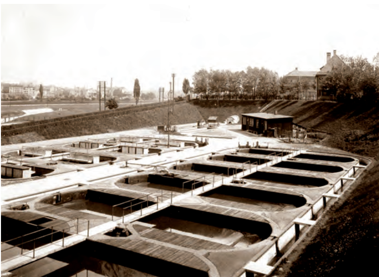
Die Kläranlage Süd nach der Inbetriebnahme der zwölf zusätzlichen Emscherbrunnens der zweiten Ausbaustufe.
