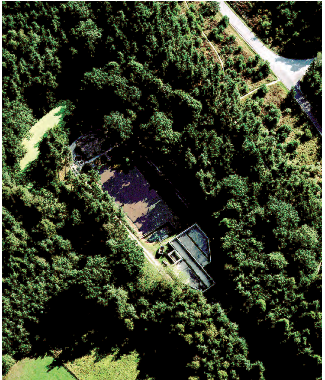
Die ehemalige Kläranlage Brunn aus der Luft, aufgenommen im Jahr 2002. (Foto: Stadtentwässerung und Umweltanalytik Nürnberg)
