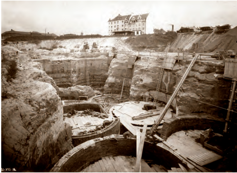
Die Emscherbrunnens der Kläranlage Süd im Bau, fotografiert im Jahr 1912.
