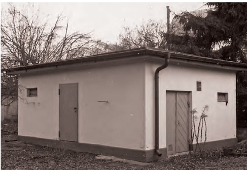
Das zu diesem Zeitpunkt bereits stillgelegte Pumpwerk auf dem Gelände der Kläranlage Zerzabelshof, fotografiert im Jahr 1995.
