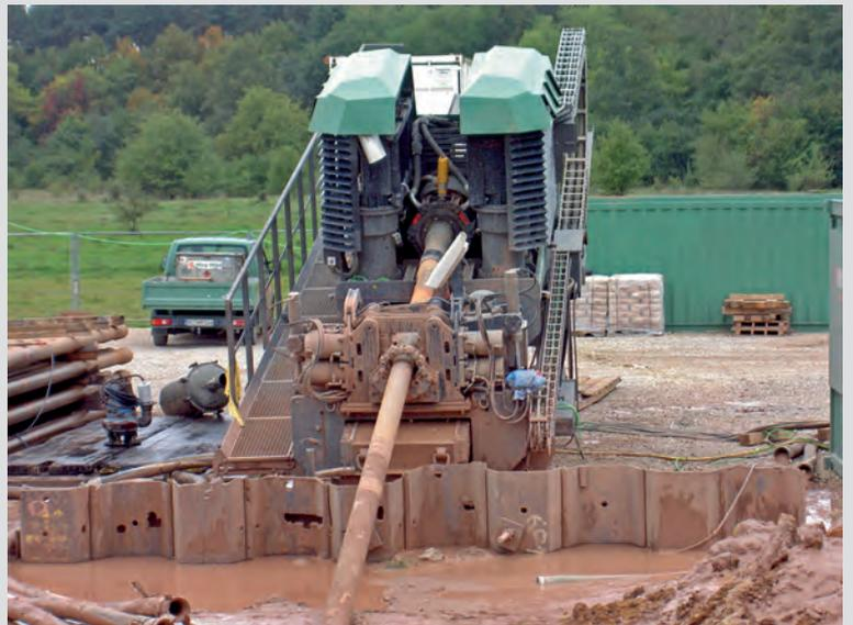
Die Horizontalspülbohrung in Aktion: Westlich der Rednitz steht das Bohrgerät. Mit dem Gestänge wird die Bohrung nach Osten in Richtung Sandäcker vorgetrieben. Die Stützflüssigkeit (braun) verhindert den Einsturz des Bohrloches. Von der Baustellen-Einrichtungsfäche auf der Fläche „Sandäcker“ holt sich das Bohrgerät den vorgefertigten Strang aus Stahlrohren. In diesen Rohrstrang wird dann das eigentliche Abwasser-Druckrohr aus Kunststoff eingezogen.
