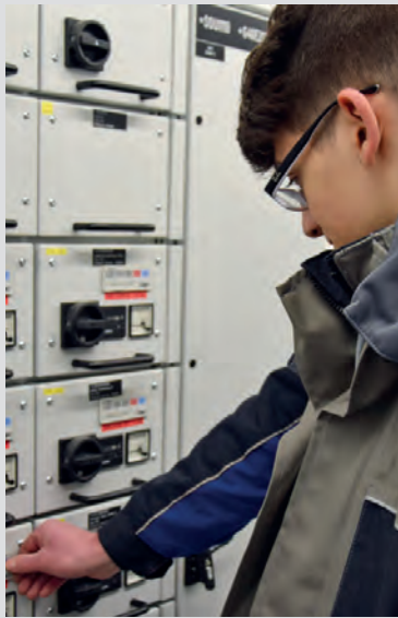
Arbeiten an Schaltanlagen (Elektroniker/in für Betriebstechnik).
