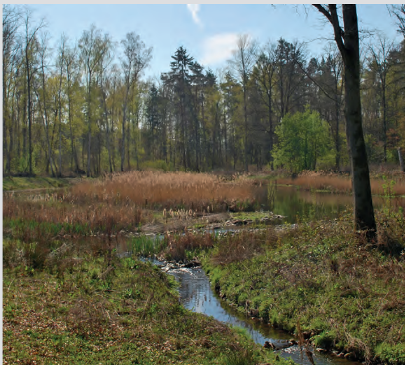
Das neu gestaltete Regenrückhaltebecken Langwasser. In der Bildmitte der mittlerweile gut aufgewachsene Schilfbestand. Foto: Hölzer (SUN).
