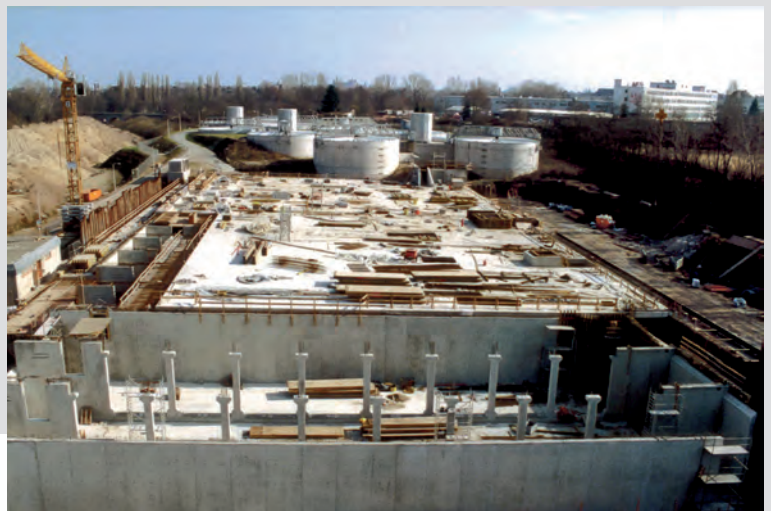
Dieses Foto, während der Bauarbeiten im März 1998 aufgenommen, zeigt die Aufteilung des Regenbeckens in einzelne Kammern. Foto: SUN.
