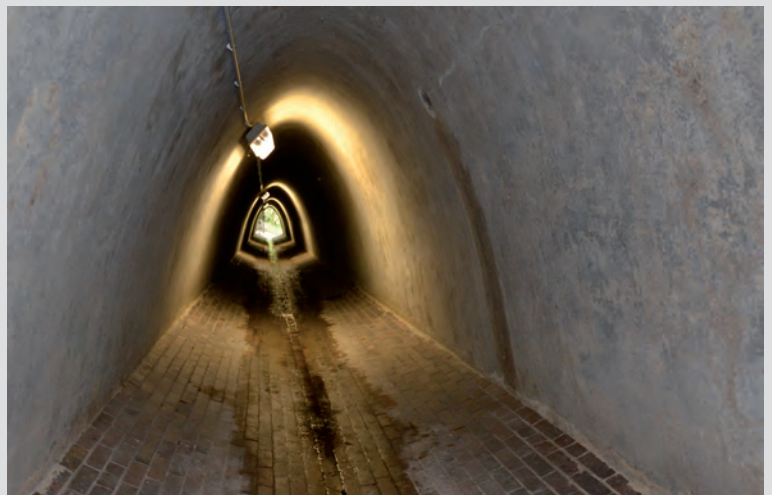
Sturmauslass Nördlicher Hauptsammler, Auslaufkanal.
