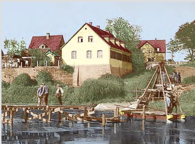
Im Jahr 1930 ist die Dükerleitung des Nördlichen Hauptsammlers im Bau. Hinter dem Montagebock befindet sich der Sturmauslass. Foto: Stadtarchiv Nürnberg.
