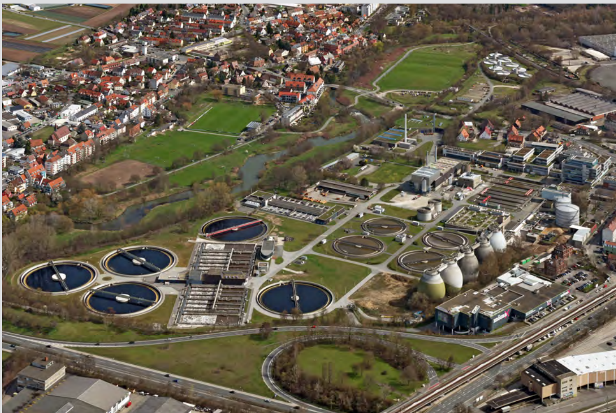
Das Klärwerk 1 aus der Luft. Foto: Nürnberg Luftbild, Hajo Dietz.
