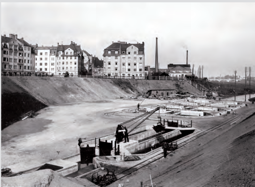
Die Kläranlage Süd (heute Klärwerk 2) kurz nach ihrer Fertigstellung im Jahr 1913. Sie war die erste große Kläranlage in Bayern. (Foto: Stadtarchiv Nürnberg)
