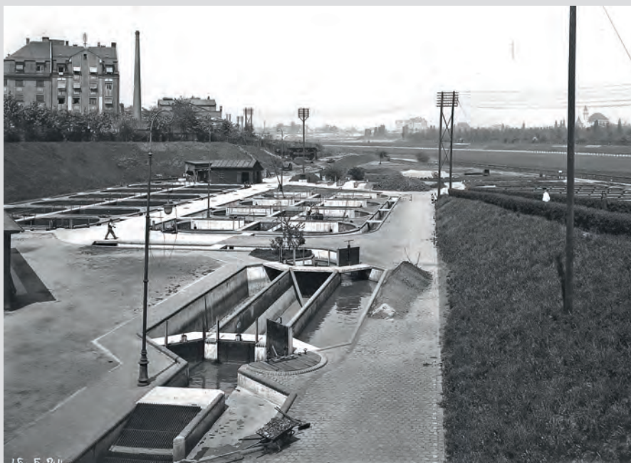
Die Kläranlage Süd (heute Klärwerk 2), fotografiert im Jahr 1924. Bei ihrer Inbetriebnahme im Jahr 1913 war sie die erste große Kläranlage in Bayern. Foto: Stadtarchiv Nürnberg.
