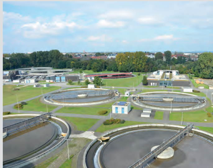
Ein Blick auf das Klärwerk 1.
