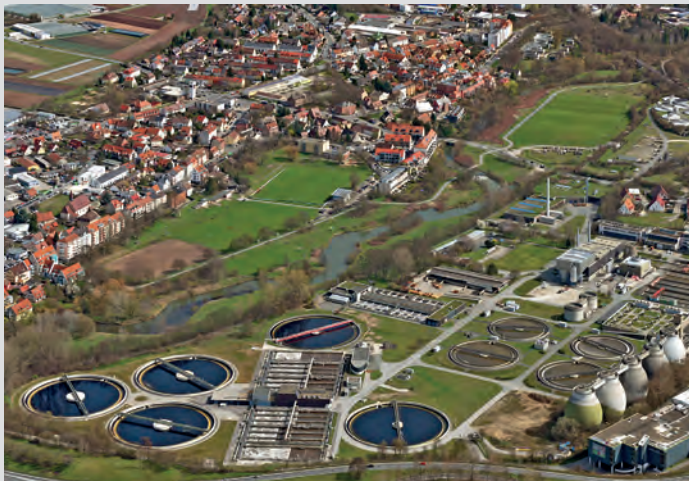
Das Klärwerk 1 aus der Luft (Foto: www.nuernbergluftbild.de )
