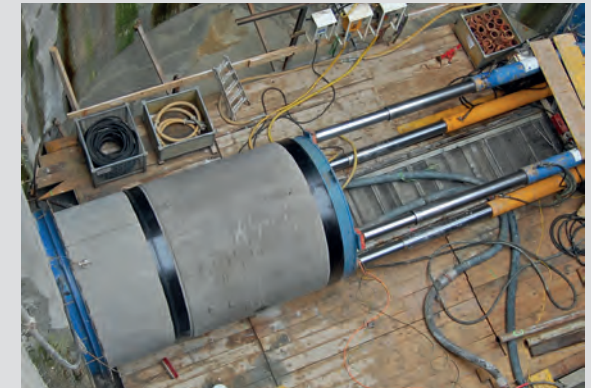
Ein Beispiel unserer zahlreichen Kanalbaumaßnahmen:
