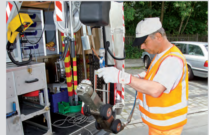
Mitarbeiter des Kanalbetriebs bei der Arbeit: Hochdruck-Spülfahrzeug und Kanalfernauge. (Fotos: www.fotografieseitz.de )
