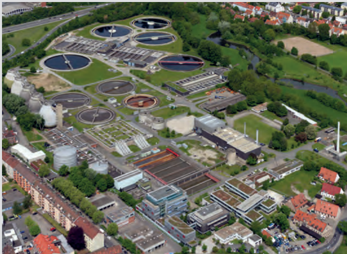
Das Klärwerk 1 aus der Luft (Foto: www.nuernbergluftbild.de )
