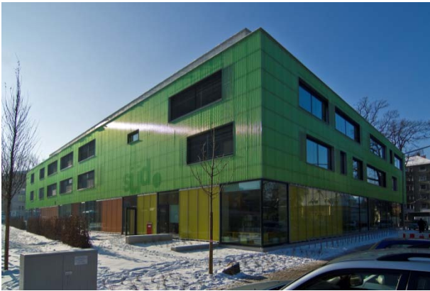
Südpunkt: Sanierung/Neubau im Passivhausstandard
