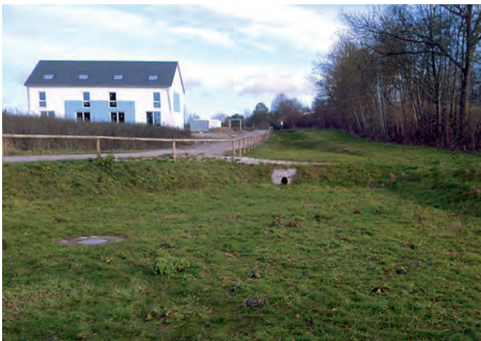
Beispiel einer Muldenversickerungs-Anlage. (Foto: SUN)
