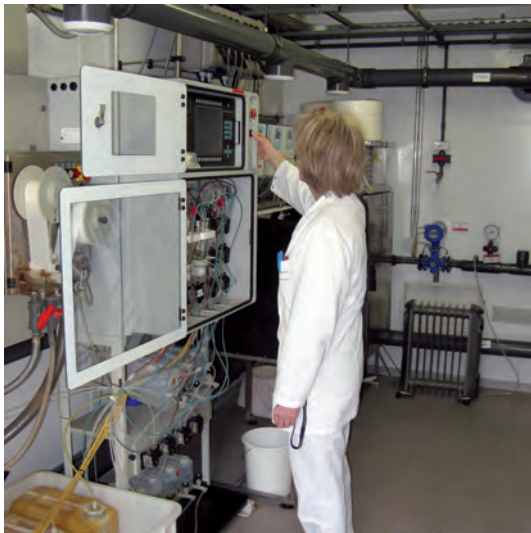
Inneres der Messstation Neumühle.
