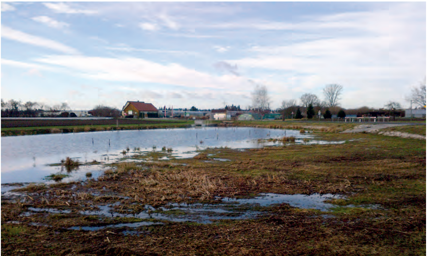
Rückhaltebecken für Regenwasser im Norden von Nürnberg. (Foto: SUN)
