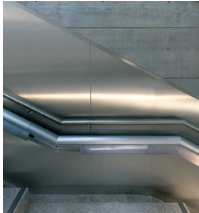
Die Treppenanlage kurz vor Fertigstellung am Ausgang Bahnhof Nordwestring.
