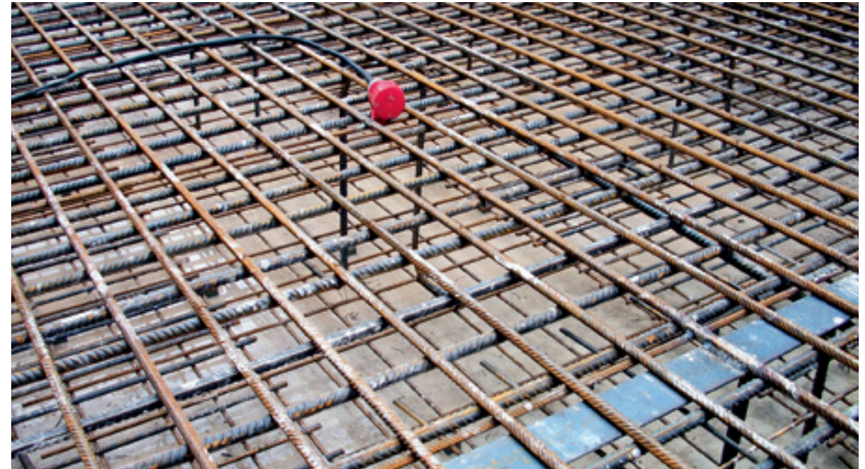
Bewehrung im Bahnhofsbauwerk.
