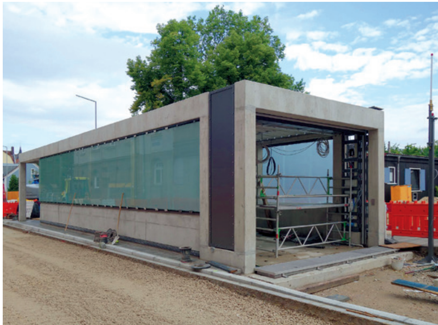
Bahnhof Klinikum Nord: Montage der Verglasungselemente am Aufgangsbauwerk.
