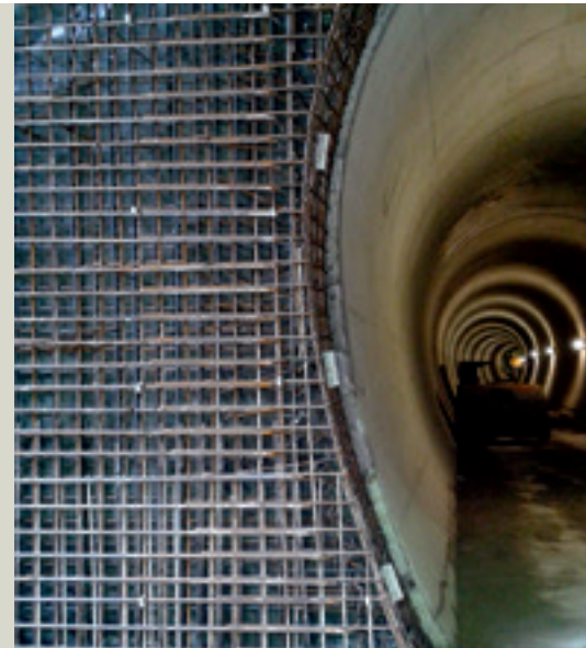
Bewehrung der Brillenwand (Bereich zwischen den Tunnelröhren).
