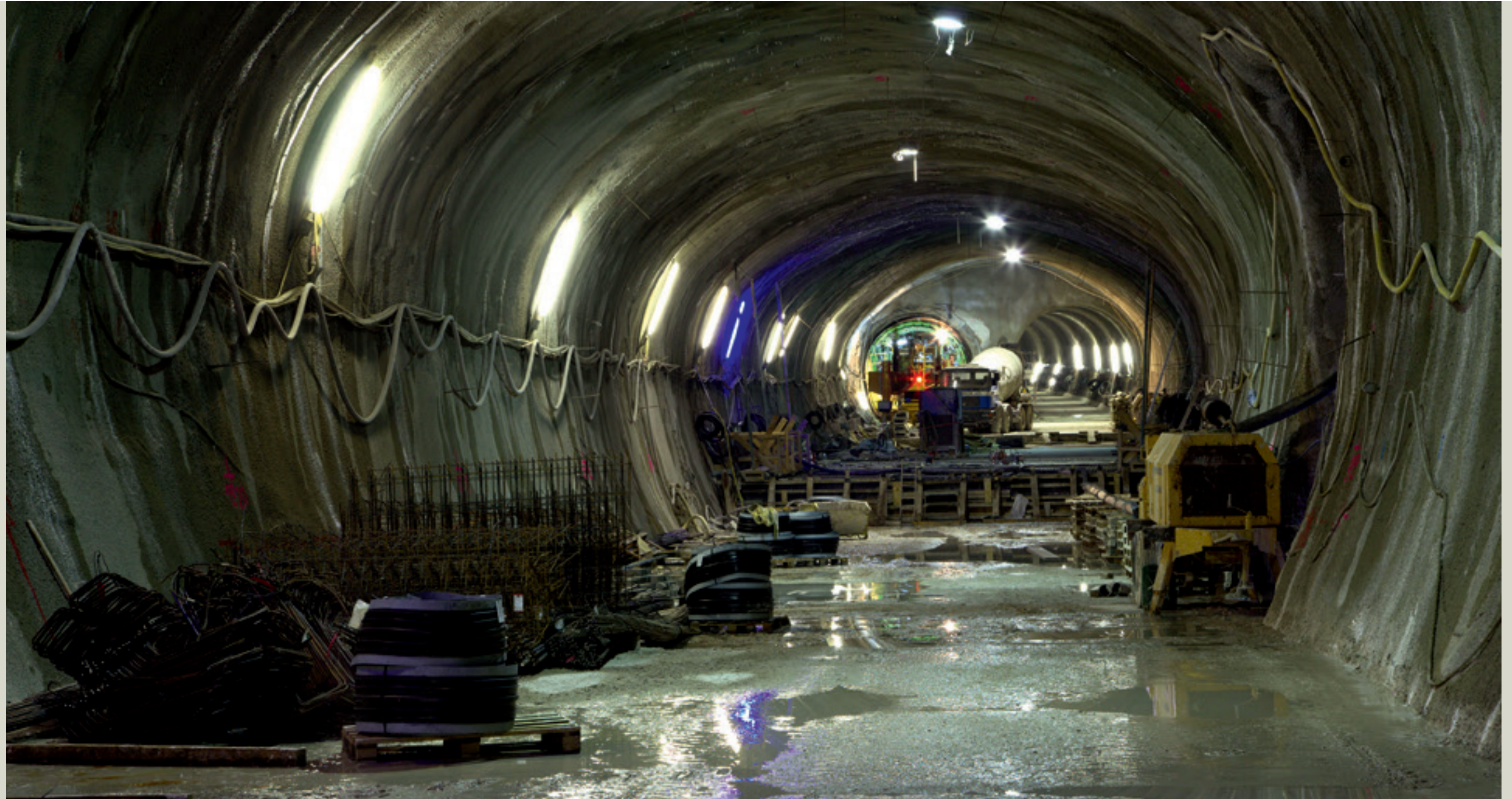
Im Tunnel: Zustand nach den Vortriebsarbeiten.
