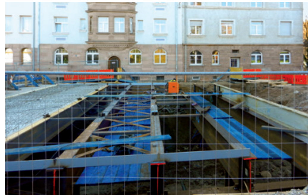
Hilfsbrückeneinbau an der Heimerichstraße.
