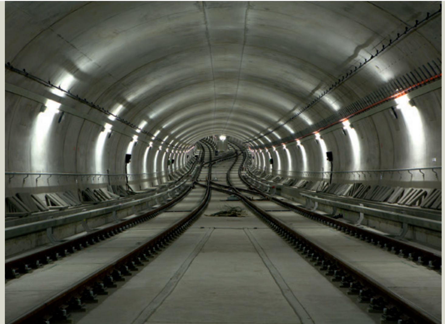
Im Tunnel: Blick in Richtung Bahnhof Klinikum Nord.
