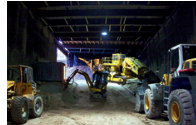
Schweres Gerät im Bahnhofsbauwerk Nordwestring.
