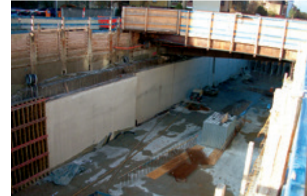
Betonieren von Sohlen und Wänden am Bahnhof Nordwestring.
