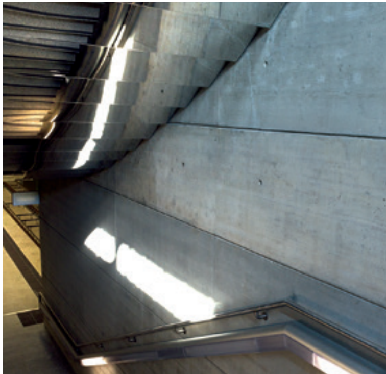
Fortführung der Spiegeldecke am Ausgang Bahnhof Nordwestring.
