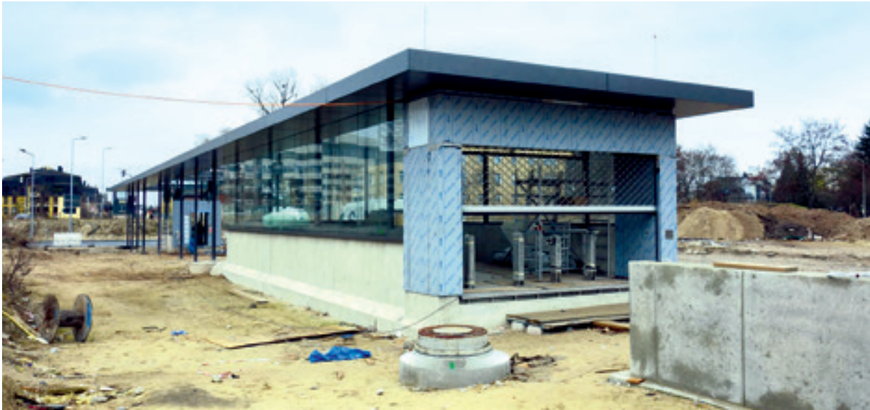
Endmontage am Aufgangsbauwerk Nordwestring Ostseite.
