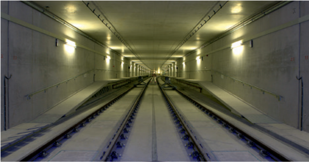
Blick in die Wendeanlage.
