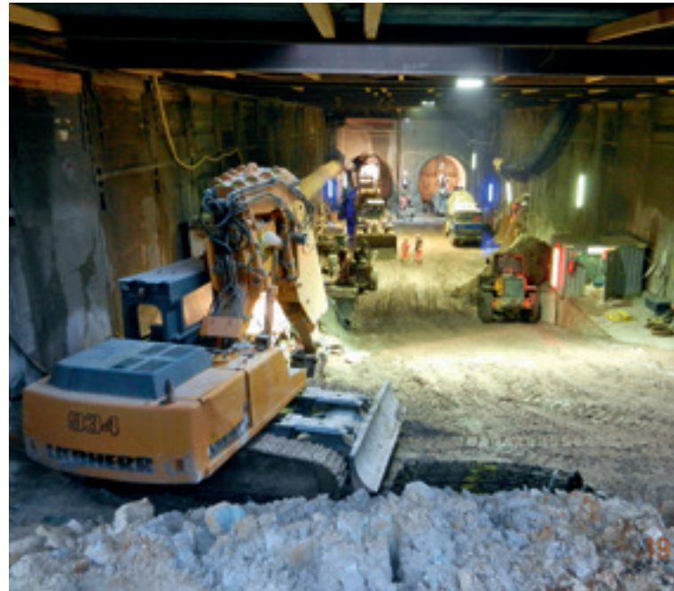
Schweres Gerät am Bahnhofsbaupunkt Nordwestring.
