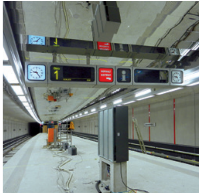
Der Bahnhof Nordwestring im Endausbau.
