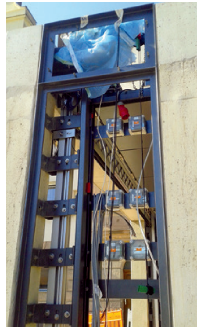
Bahnhof Klinikum Nord: Montage des Rolltors am Aufgangsbauwerk.
