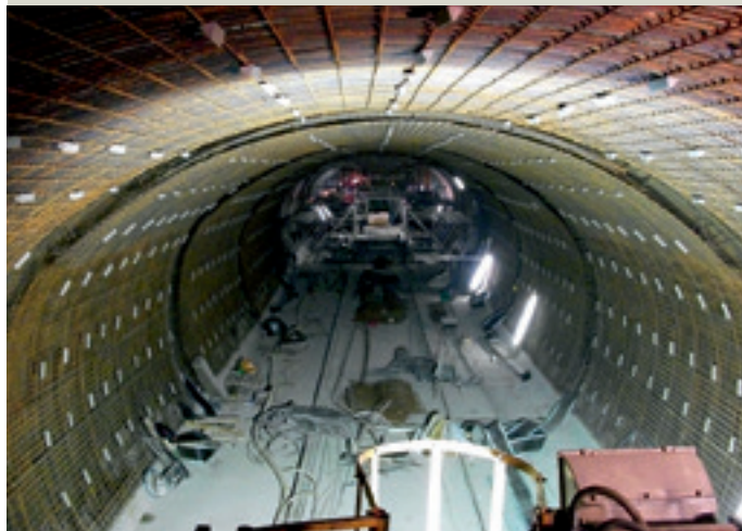
Montage der Stahlbewehrung.
