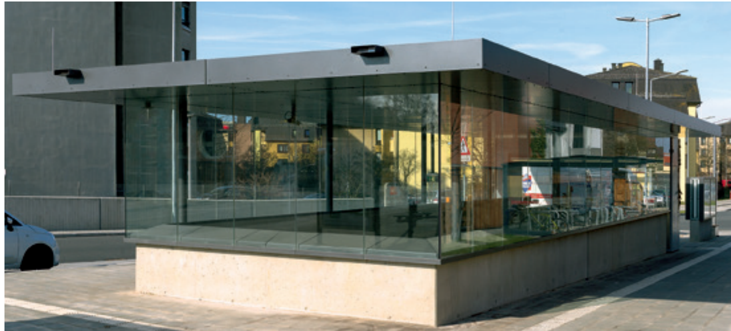
Das Aufgangsbauwerk an der Westseite des Bahnhofs Nordwestring.
