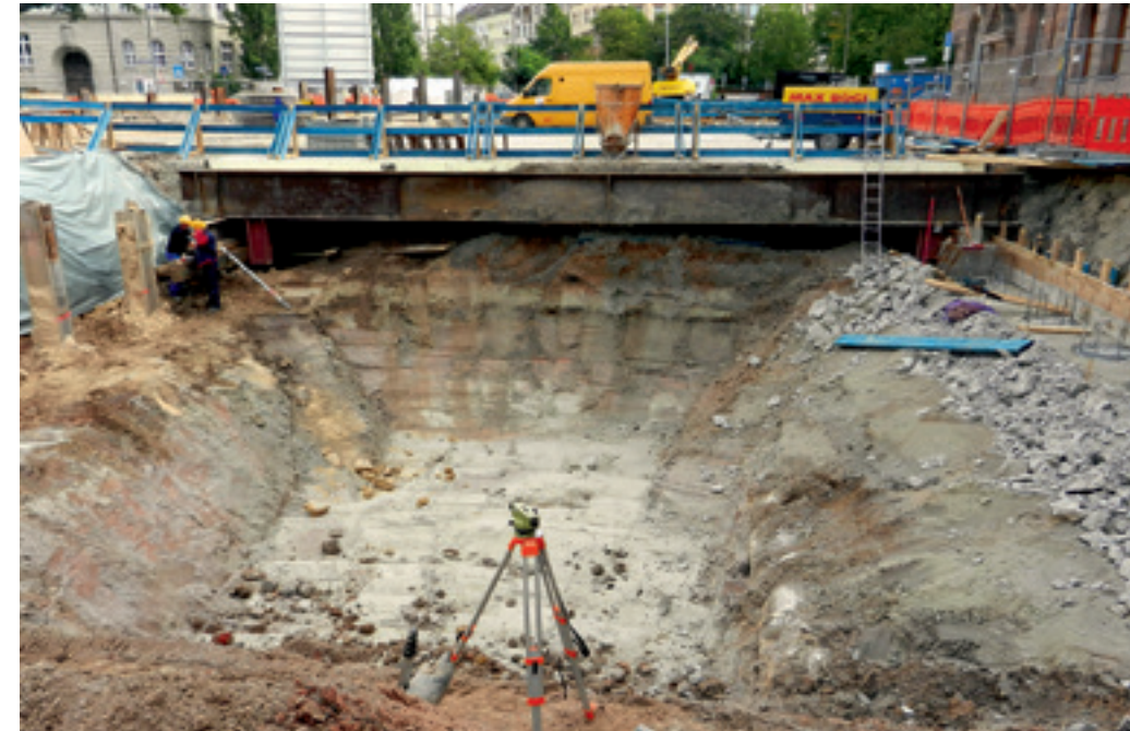
Aushub für Hilfsbrücken in der Heimerichstraße.
