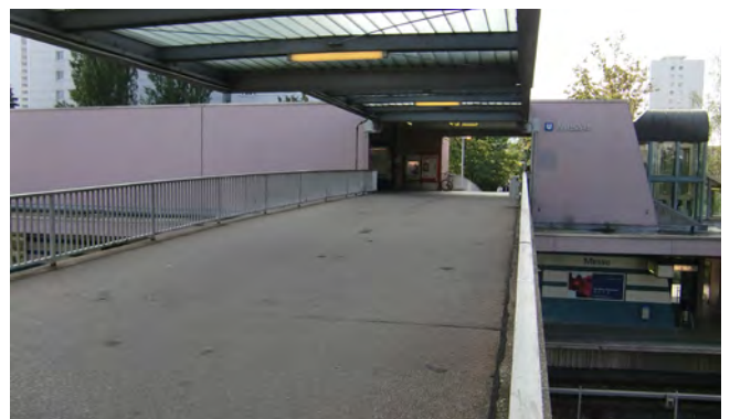
Abb. 40: Handlungsbedarf besteht beispielsweise auch beim U-Bahnhof Messe.
