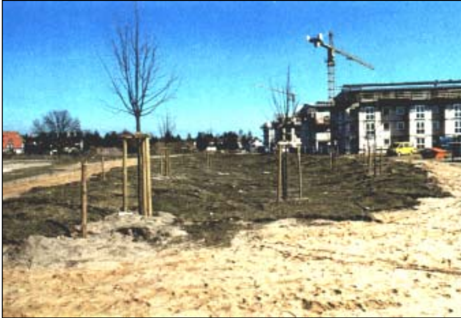
Versickerungsmulde Wohnanlage „Langsee“
