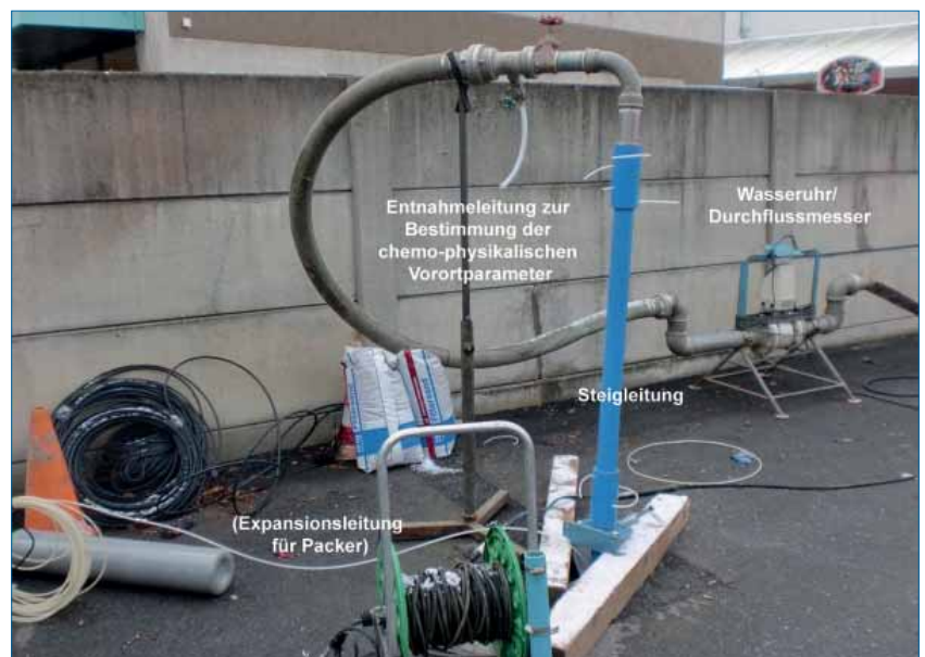
Abbildung 36: Durchführung eines Pumpversuches mit messtechnischer Ausstattung (Foto: TÜV Rheinland LGA Bautechnik GmbH)
