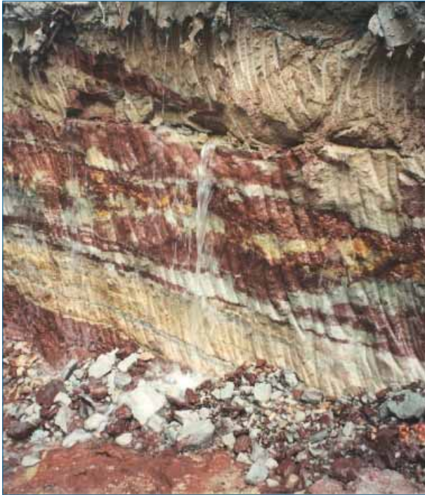
Abbildung 37: Offenes Kluftsystem mit Wasseraustritten an der Schichtgrenze Blasensandstein / Lehrbergsschichten (IMAX-Baugrube, Nürnberg, 2000, Foto: TÜV Rheinland LGA Bautechnik GmbH)
