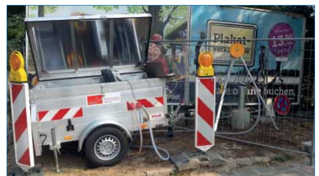
Abbildung 65: Einsatz der Pumpbox bei einem Immissions-Pumpversuch (Quelle: Stadt Nürnberg, Stadtentwässerung und Umweltanalytik Nürnberg)
