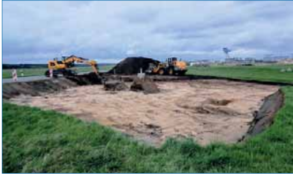
Abbildung 109: Löschbecken West – Pilotversuch Bodenaustausch (Quelle: albuCon GmbH)
