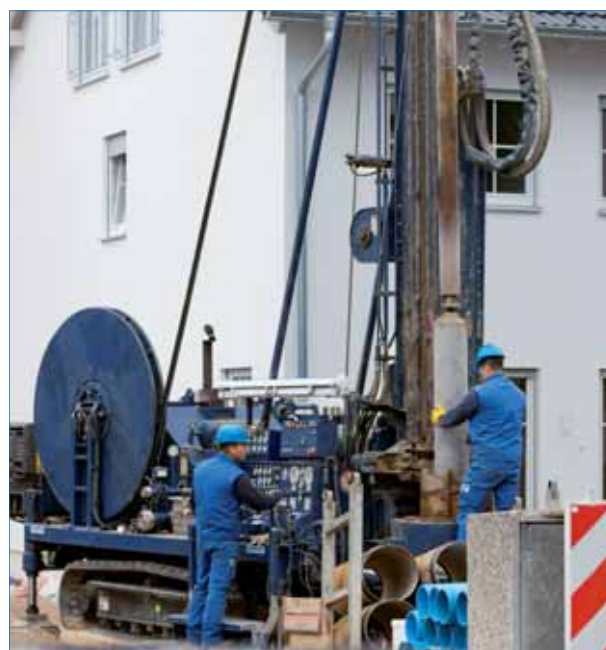
Abbildung 81: Durchführung einer Brunnenbohrung im Wohnungsbau (Quelle: Baugrund Süd Gesellschaft für Geothermie mbH)
