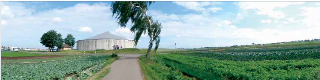
Abbildung 30: Ansicht Hochbehälter Buch (Quelle: Wasserverband Knoblauchsland)
