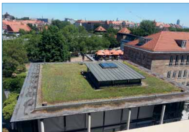
Abbildung 16: Dachbegrünung auf dem Gebäude des CINECITA, gesehen vom Dach der Stadtbücherei (Quelle: Stadt Nürnberg, Umweltamt)
