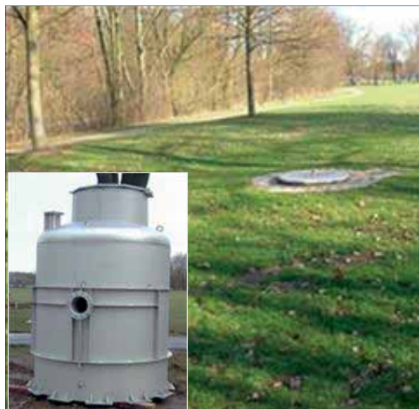
Abbildung 27: Brunnenvorschacht vor und nach dem Einbau (Quelle: Wasserverband Knoblauchsland)
