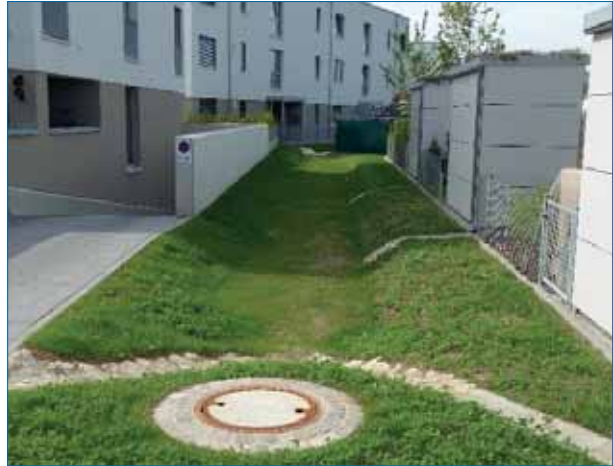
Abbildung 128: Muldenversickerung in Großreuth b. Schweinau (Quelle: Stadt Nürnberg, Umweltamt)
