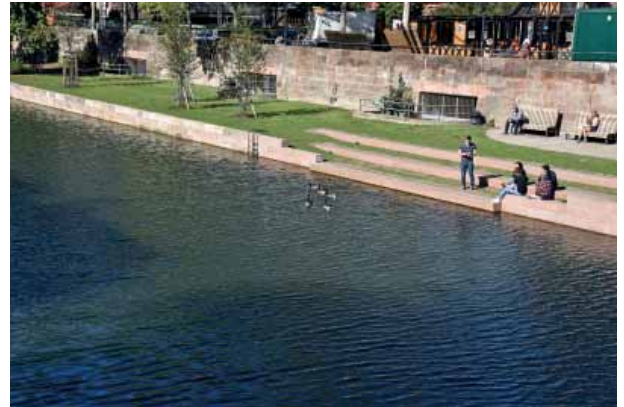
Abbildung 10: Umgestaltetes Südufer der Insel Schütt (Quelle: Stadt Nürnberg, Presse- und Informationsamt)
