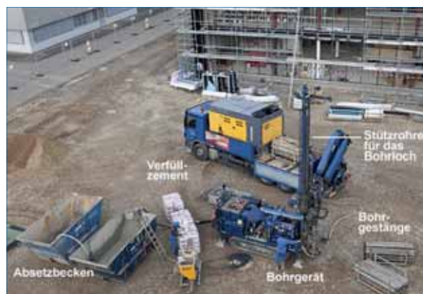
Abbildung 80: Herstellung einer Erdwärmesondenanlage im Gewerbebau (Quelle: Baugrund Süd Gesellschaft für Geothermie mbH)
