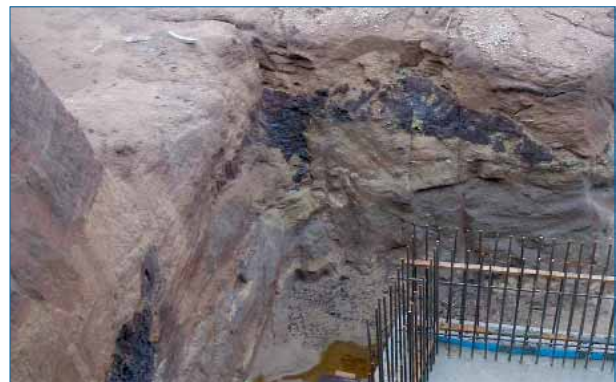
Abbildung 34: Unterer Burgsandstein mit Lettenlagen. Baugrube des Delfinariums im Tiergarten zu Nürnberg. (Foto: BAIER, GeoZentrum Nordbayern der FAU Erlangen-Nürnberg)
