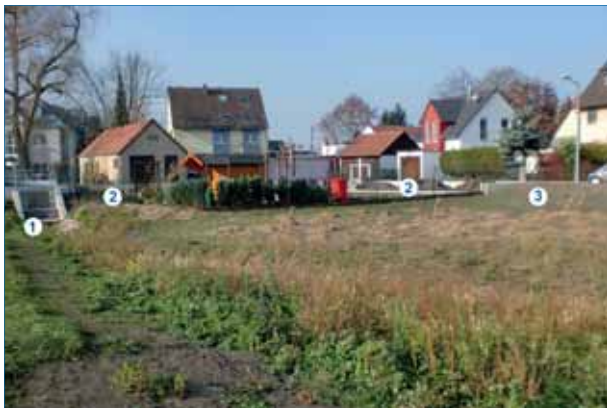
Abbildung 1: Technische Hochwasserschutzmaßnahme zur Hochwasserfreilegung Ziegelsteins Von links nach rechts: 1) Steuerungsbauwerk für den regulierten Ablauf aus der Retentionsfläche im Vordergrund „Am Anger“ (Hirschsprunggraben); 2) Hochwasserschutzmauer (weiß) hinter dem Gartengrundstück und entlang der Straße „Am Anger“ 3) im Anschluss daran Hochwasserschutzdamm (Quelle: Stadt Nürnberg, Service Öffentlicher Raum (SÖR) / Brückenbau und Wasserwirtschaft)
