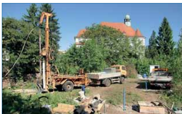
Abbildung 125: Sanierungsarbeiten auf einem ehem. Tankstellenstandort (Quelle: Stadt Nürnberg, Umweltamt)
