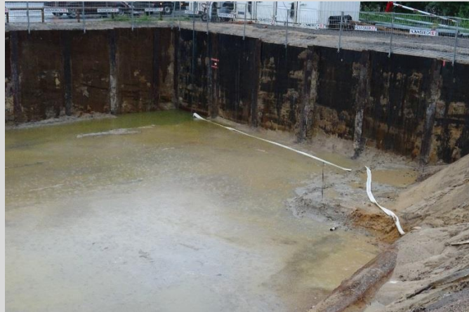
Baugrubensicherung über Spundwände
