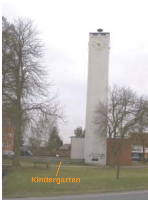
Turm der freiwilligen Feuerwehr in Nürnberg-Worzeldorf
