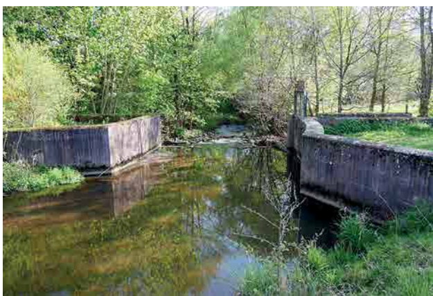
Abb. 53: Abschlagsbauwerk Gründlach - Mühlbach
