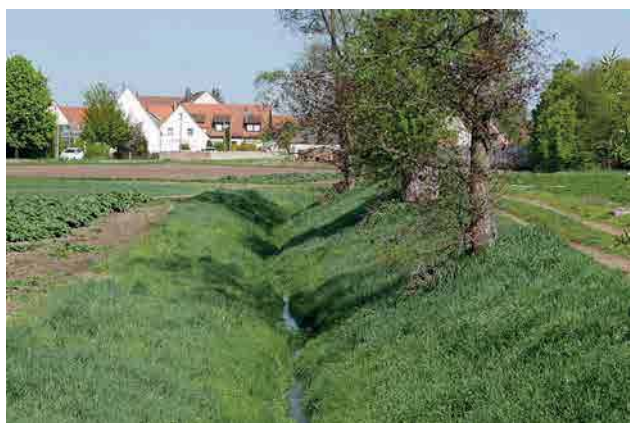
Abb. 40: Begradigter Lauf des Kothbrunngrabens westlich Kraftshof
