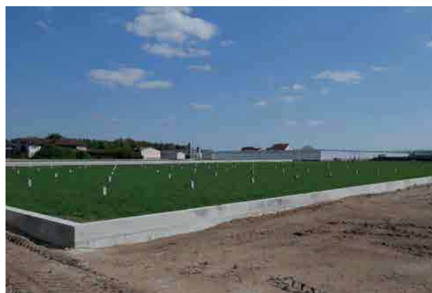
Abb. 89: Großflächiger Unterglasanbau bei Kraftshof
