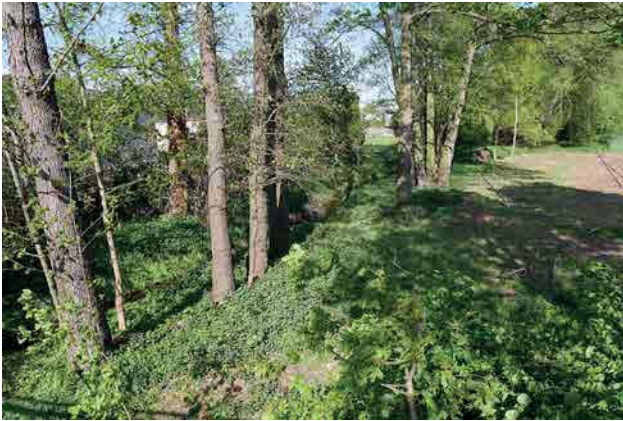
Abb. 118: Fehlender Landschaft-Zugang Boxdorf: Moosfeldweg - Kothbrunngraben
