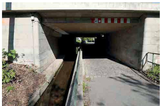
Abb. 117: Unterführung bei Boxdorf
