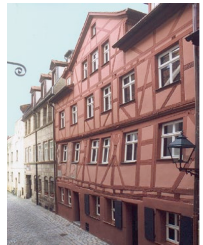
Bild 2: denkmalgeschütztes Fachwerkgebäude vor und nach der Sanierung
