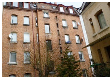
Bild 21: Außenwanddämmung der Hoffassade mit WDVS möglich
