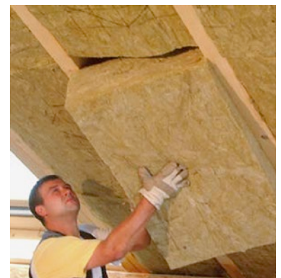
Bild 26: Zwischensparren-dämmstoff sparrenhoch einbauen (Quelle: Energiesparinfo 6 aus Hessen)
