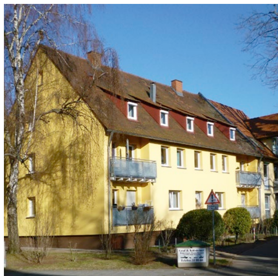
Bild 24: Wohngebäude aus dem 50er Jahren mit einem WDVS
