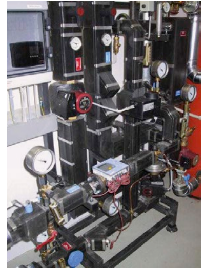
Bild 11: Fernwärmeübergabestation
