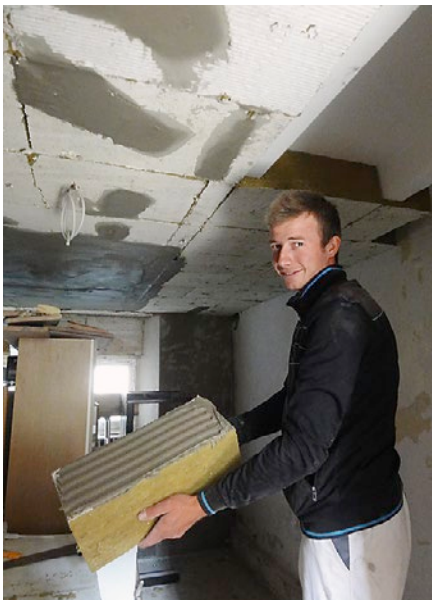
Bild 29: Kellerdeckendämmung mit 16 cm Mineralwolle (Quelle: Rupert Diels, Architekt)
