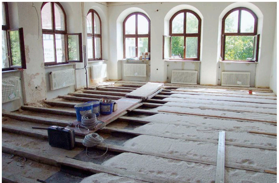
Bild 30: Dämmmaßnahmen der Kellerdecke oberhalb der Decke (Quelle: Stadt Nürnberg, Kommunales Energiemanagement)
