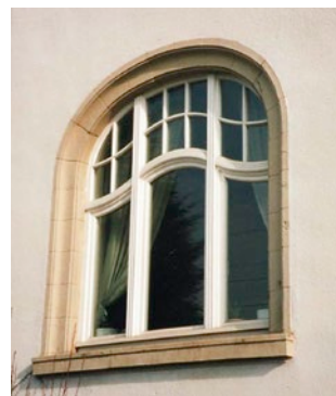
Bild 28: Fenstererneuerung in einem historischen Gebäude (Quelle: Energie- sparinfo 1, Hessen)
