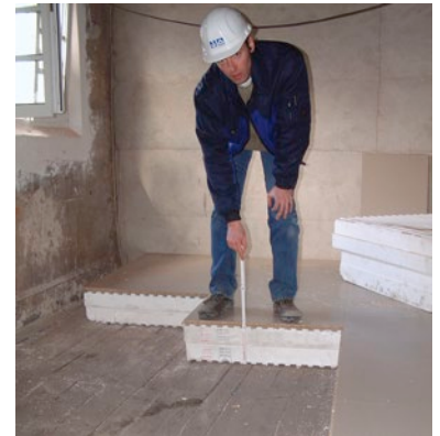
Bild 25: Dämmung der obersten Geschossdecke
