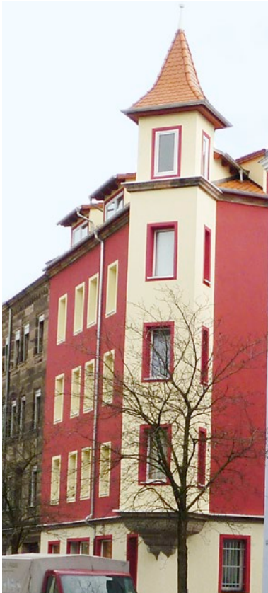
Bild 14 : gedämmtes (erhaltenswertes) Gebäude
