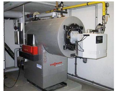
Bild 3: Gasbrennwertanlage
