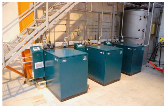
Bild 6: Blockheizkraftwerk (Quelle: Senertec)
