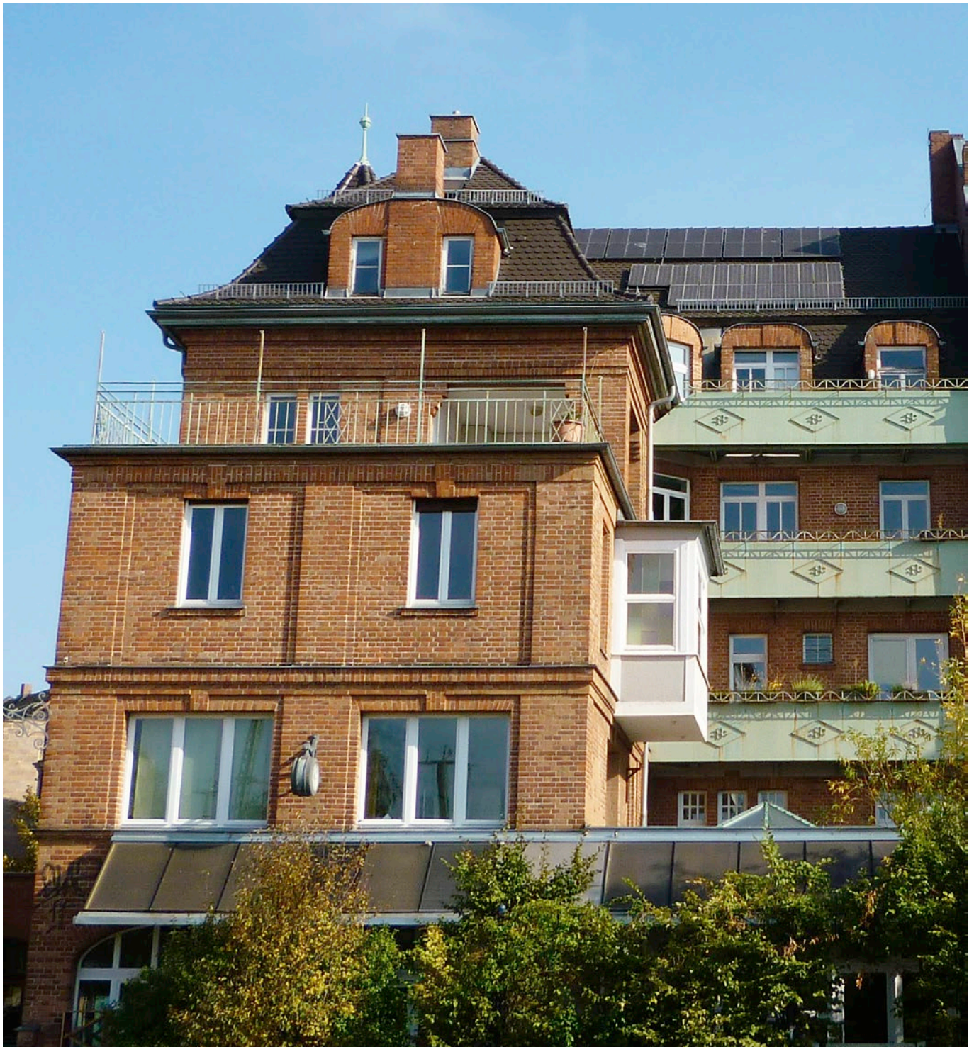
Bild 17 : Gebäude mit Sichtmauerwerk aus Ziegel
