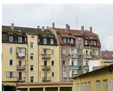
Bild 22: Hinterhoffassaden; Außenwanddämmung möglich
