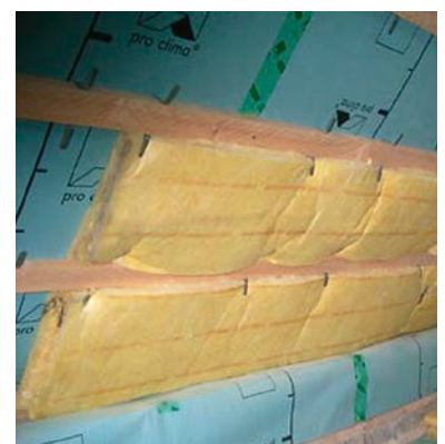
Bild 27: Untersparren-dämmung einbauen (Quelle: Energiesparinfo 6 aus Hessen)
