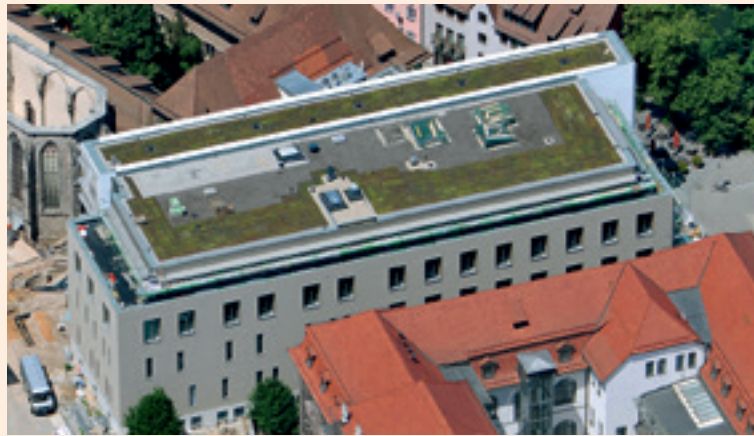
Abb. 4.11: Dachbegrünung in der Altstadt, Nonnengarten- straße
