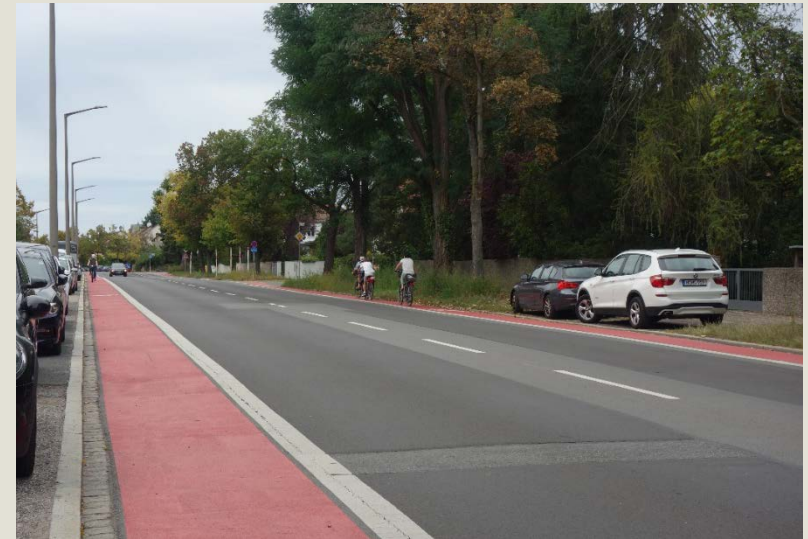
Radstreifen Thumenberger Weg, nachträglich rot eingefärbt
