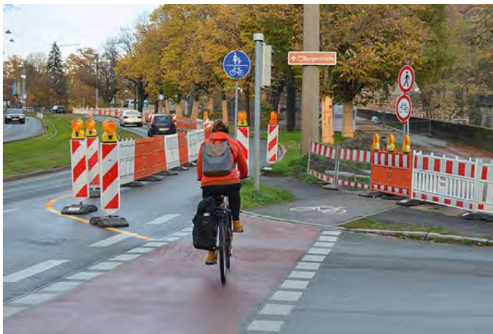
Umleitung während der Bauarbeiten am Neutor
