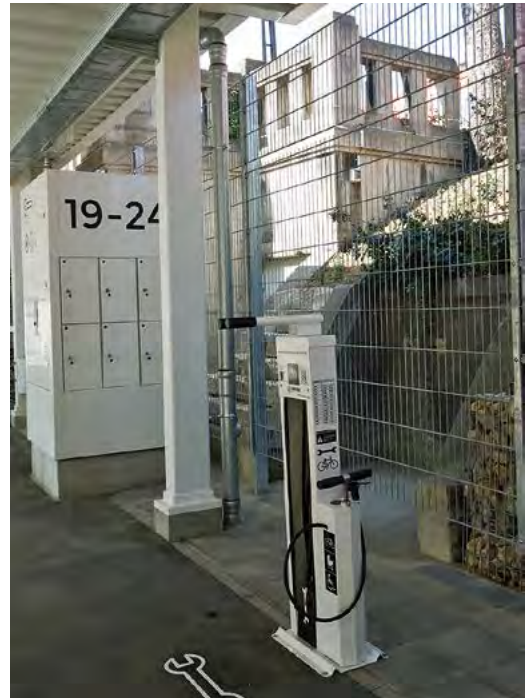
Servicestation für Radfahrende im Fahrradspeicher
