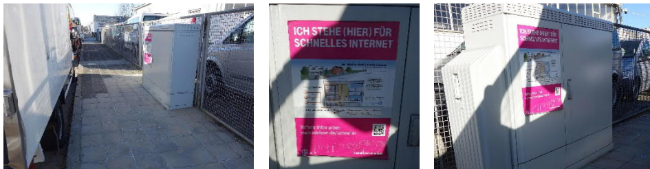
Abbildung 15: Neuer Verteilerkasten mit Glasfaser-Anschluss in der Flachslander Straße
