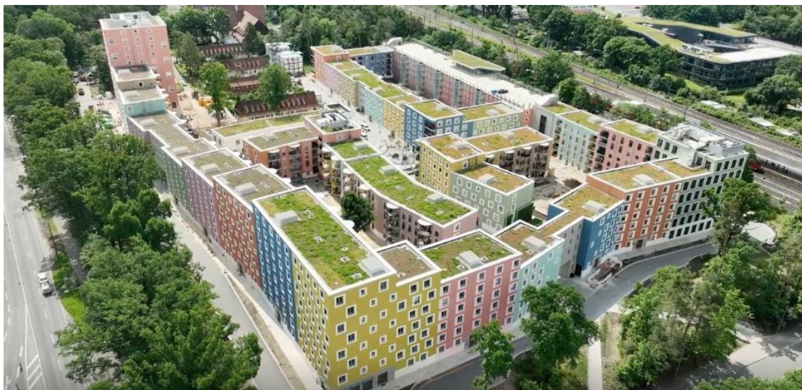
Abbildung 25: Regensburger Viertel (o.), Heinrich-Held-Straße (u.l.), Reinerzer Straße (u.r.)
