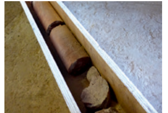
Die Bohrkern geben Aufschluss über den Zustand der Materialien in der Zeppelintribüne.
