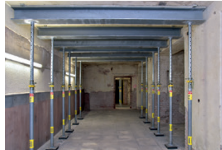
Sicherung im Inneren der Zeppelintribüne mit Stahlstützen.
